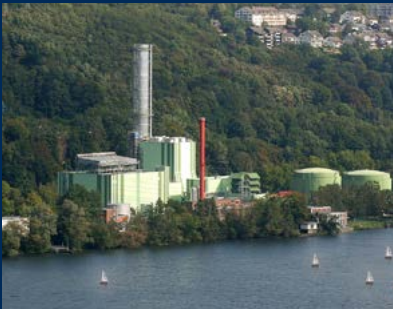
Gas-Kraftwerk Herdecke, Deutschland
